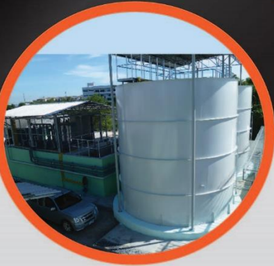
ระบบบำบัดน้ำเสียแบบ ASBR ของโรงงาน บริษัท ไทย สฟิรริท อินดัสทรี จำกัด
