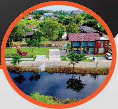
ระบบบำบัดน้ำเสียแบบ ASBR ของ องค์การจัดการน้ำเสีย เทศบาลตำบลสามควายเผือก จ.นครปฐม ( เป็นระบบบำบัดน้ำเสียที่ก่อสร้างและ ติดตั้งเครื่องจักรไต่ดินทั้งระบบ )
