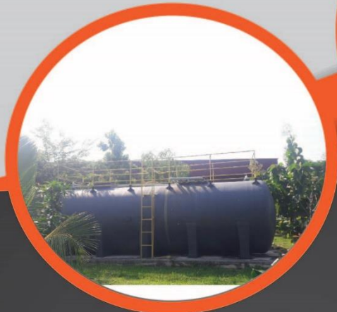
ระบบบำบัดน้ำเสียแบบ ASBR ของโรงงานผลิตนมพาสเจอร์ไรซ์ โครงการชั่งหัวมัน
